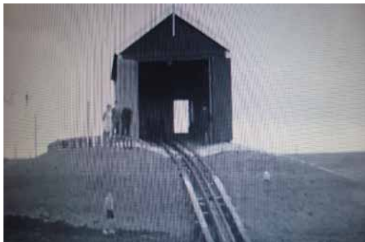
De loods van de reddingsboot, met op de voorgrond de rails waarmee de boot in en uit de loods getakeld werd. Momenteel is dit ongeveer de plaats van het monument van de redders van Burghsluis.
