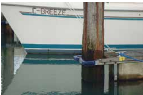
Twee beschermkappen aangebracht op een vingerpier
